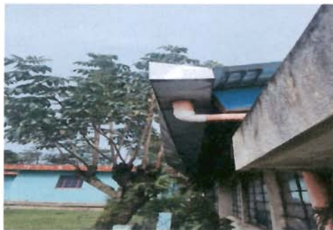
Foto 5: Sustitución de canal de metal y reparación de bajada de agua pluvial tubo PVC 3"
