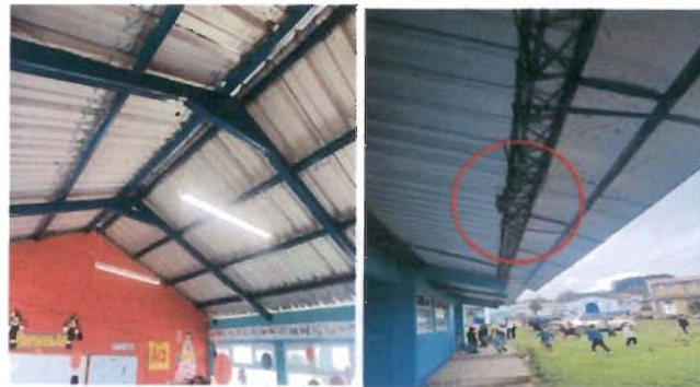
Foto 8: Sustrucción de lámparas de 2 x 40, sustrucción de focos ahorradores, sustrucción de ducto eléctrico + accesorios
