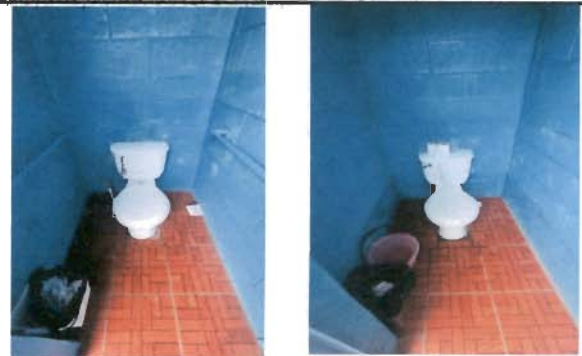
Foto 6: Sustitución de accesorios inodoro (contra llave, tubo de abasto y tanque)
