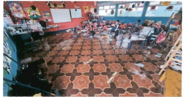
Foto 4: Sustitución de piso ceramico
