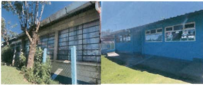
Foto 3: Sustitución de balcones de metal
